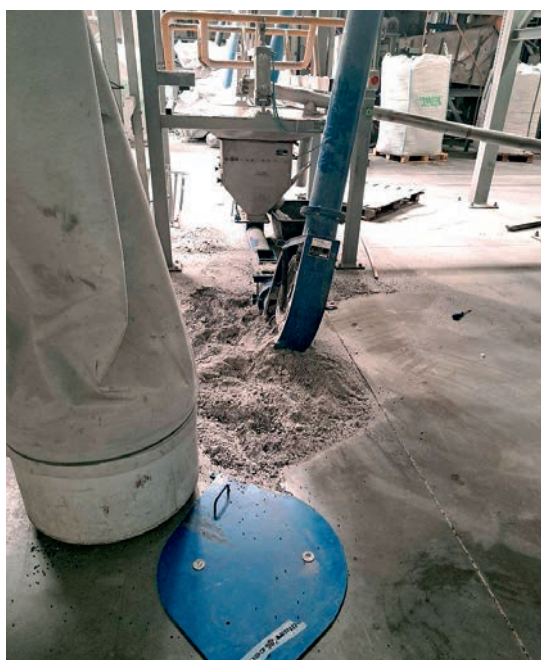
Fot. 1. Podajnik zgrzebowo-rurowy
