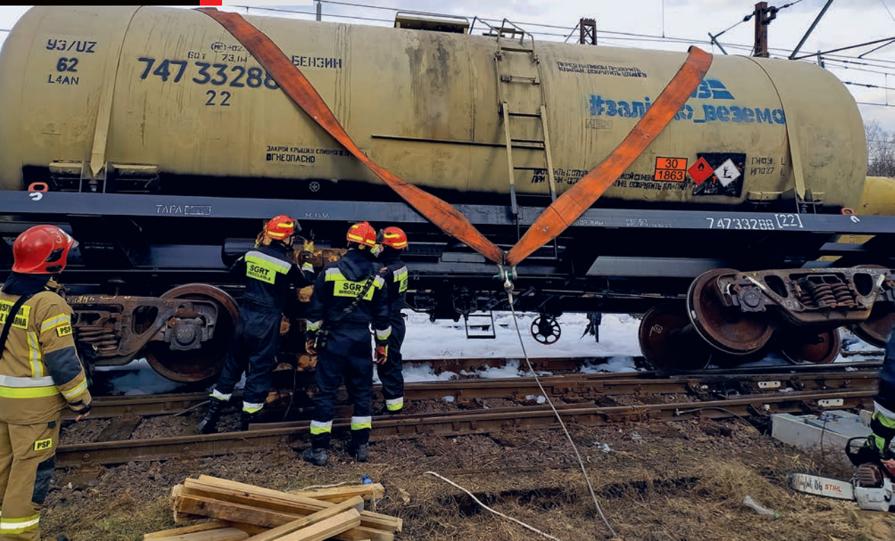
Fot. 2. Tworzenie podbudowy drewnianej w celu stabilizacji przechylonego wagonu w połączeniu z zabezpieczeniem przy zawiesi i wciągarki hydraulicznej
