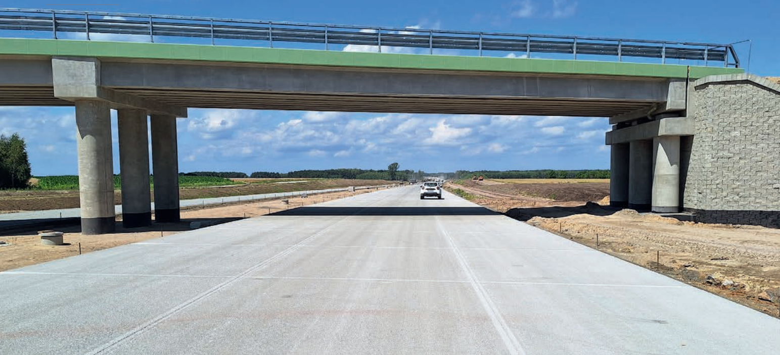
Budowana nawierzchnia betonowa A2 węzeł Groszki – węzeł Siedlce Zach
