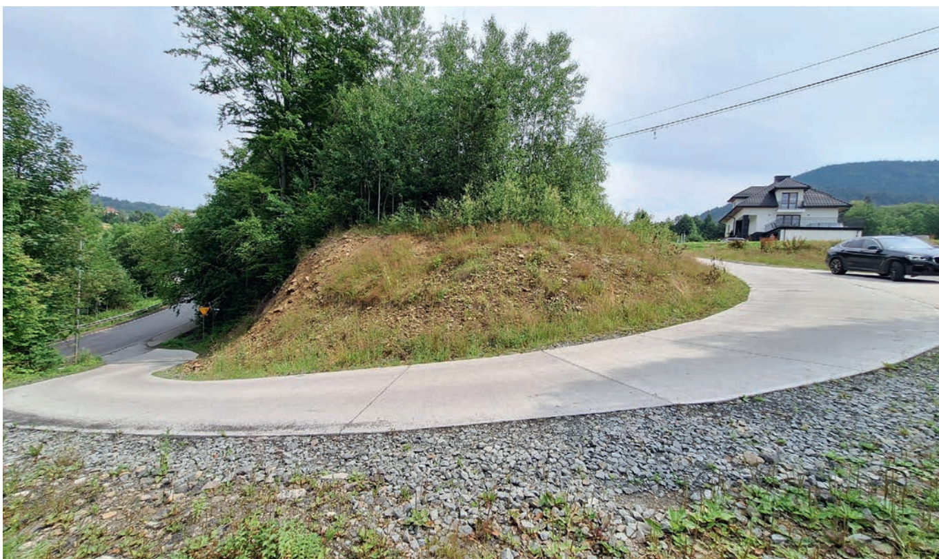
Droga betonowa w Zalesiu, gmina Kamienica (małopolskie)
