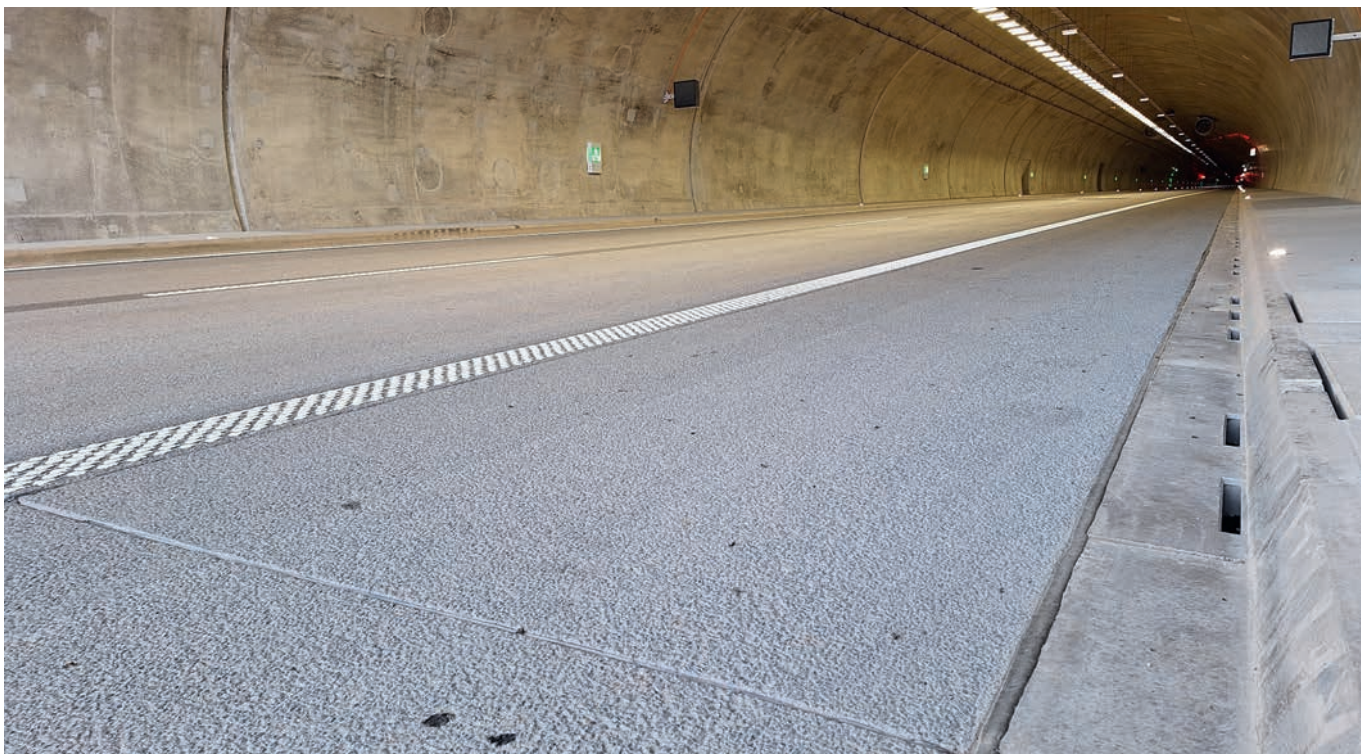
Nawierzchnia betonowa w tunelu na S3 Bolków – Kamienna Góra
