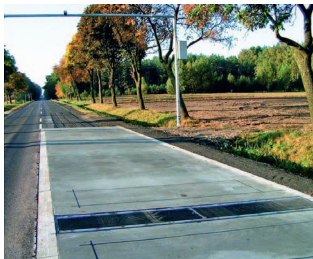
Fot. 1. Stacja preselekcyjnego ważenia pojazdów [2]
