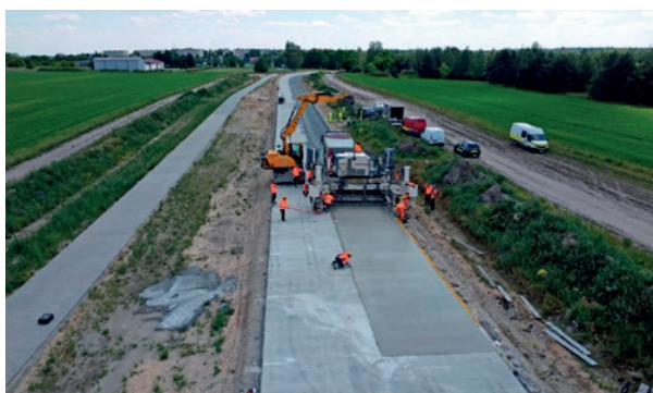
Fot. 5. Nawierzchnia betonowa układana specjalnym rozścielaczem do betonu
