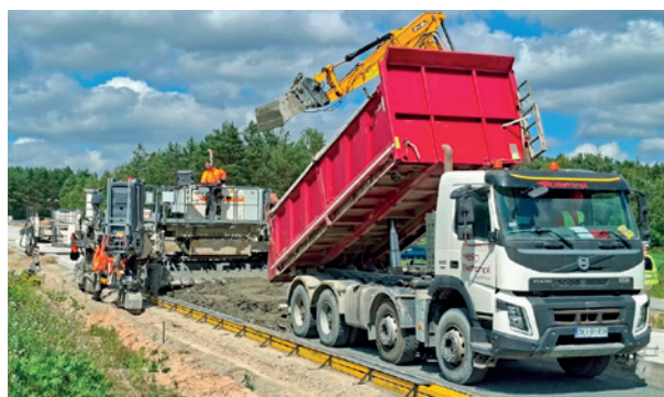
Fot. 2. Zastosowanie cementów niskoemisyjnych
