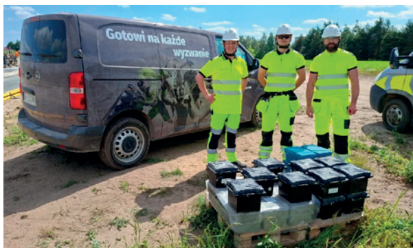
Fot. 9. Podczas budowy drogi próbki betonu do badań laboratoryjnych pobierali (od lewej): Piotr Molenda, Mikołaj Biedrzycki i Przemysław Pudlik z Cement Ożarów
