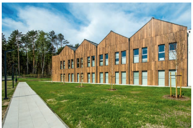
Ryc. 4. Osadzony w zieleni i zaprojektowany z uwzględnieniem optymalizacji ekologicznej Zakład Opieki Długoterminowej w Świnoujściu (proj. WK Architekci, Adam Kashyna, Piotr Springer 2017 r.). Fot. Mirbud SA
