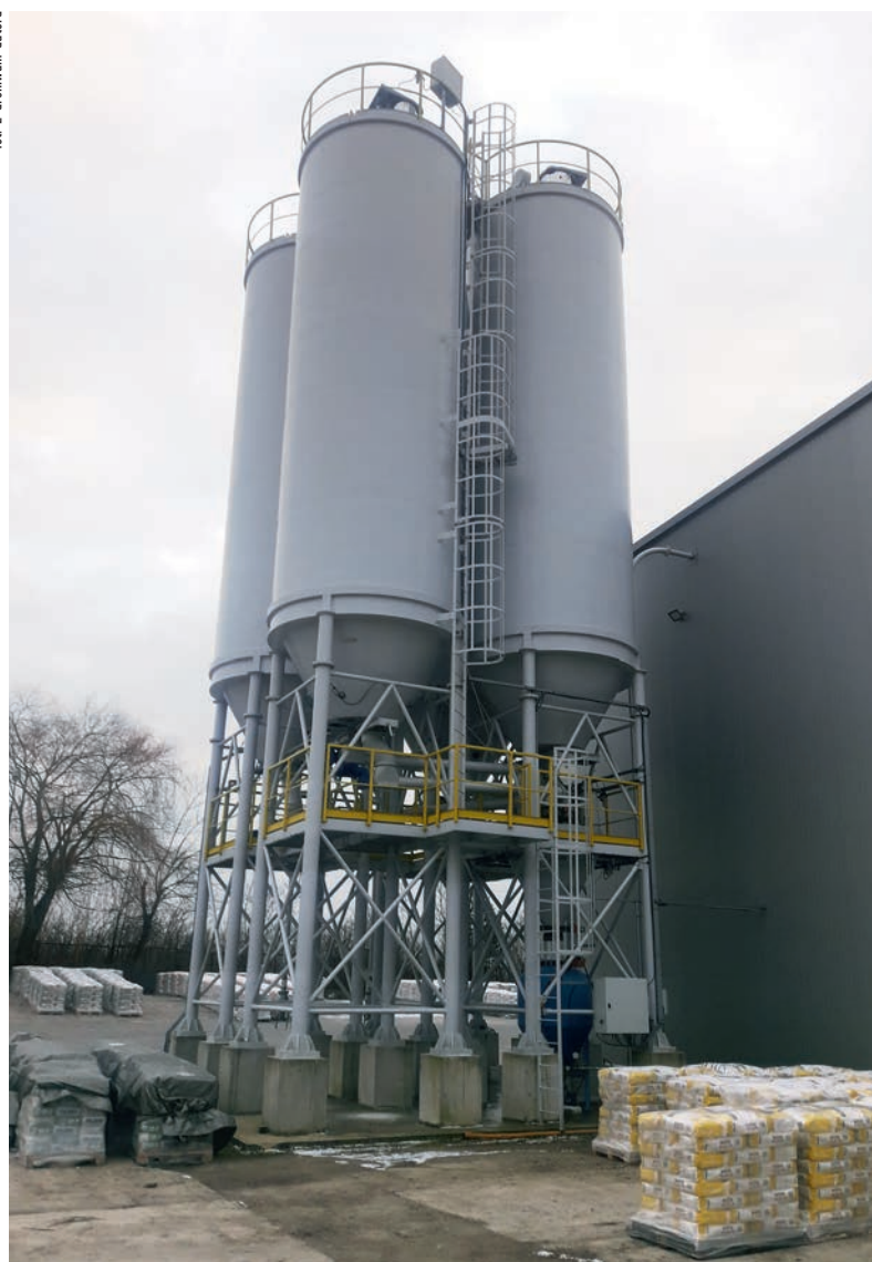
Fot. 1. Gotowe silosy przy hali produkcyjnej
